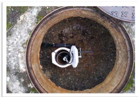
Installation d'une nouvelle centrale SEBA télétransmise à Hésingue
