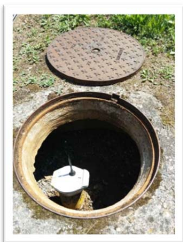
Installation d'une nouvelle centrale SEBA télétransmise à Hésingue
